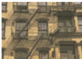
пожарная лестница požarne stepenice
